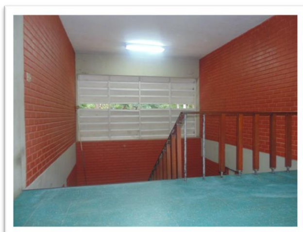
Foto 14 – Escada e janela do ICIV
